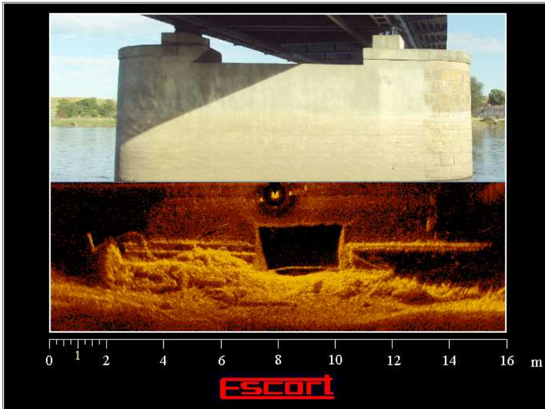
podpora mostu – strona nawodna i podwodna
